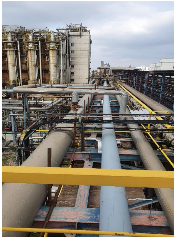
Nový parovod pary P3 DN 300 / bez izolácie / na moste X1
