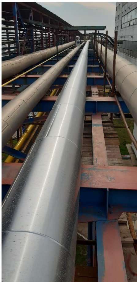
Obnova a racionalizácia rozvodu pary P3 na mostoch Q1 a X1
