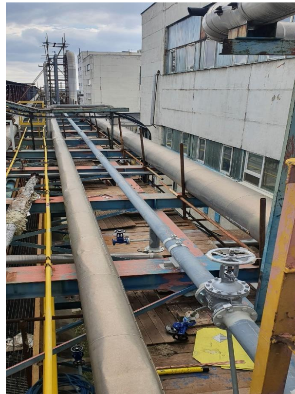
Nový parovod pary P3 DN 150 / bez izolácie / na moste X1
