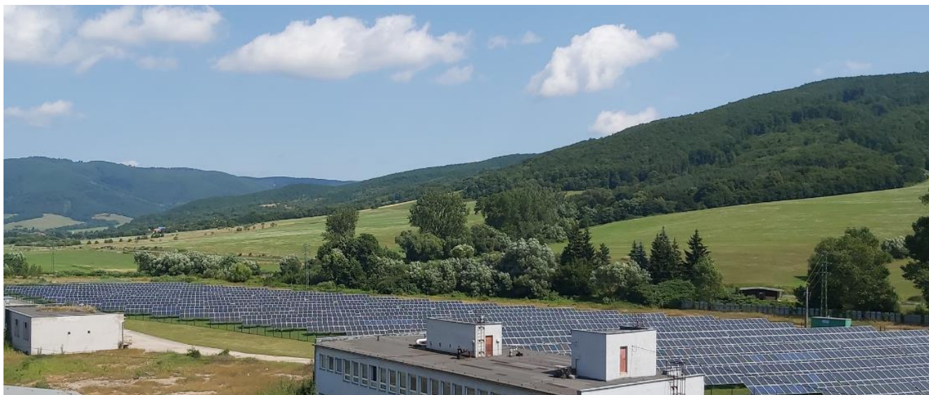
Pohľad na fotovoltickú elektrárňu v Lovinobani
