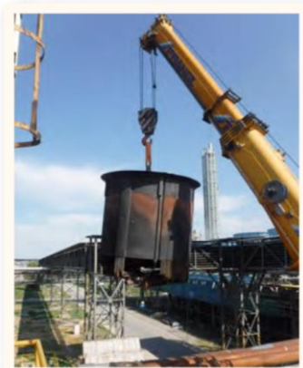
Demontáž trubkového zväzku kotla
