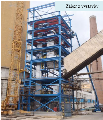
Záber z výstavby
