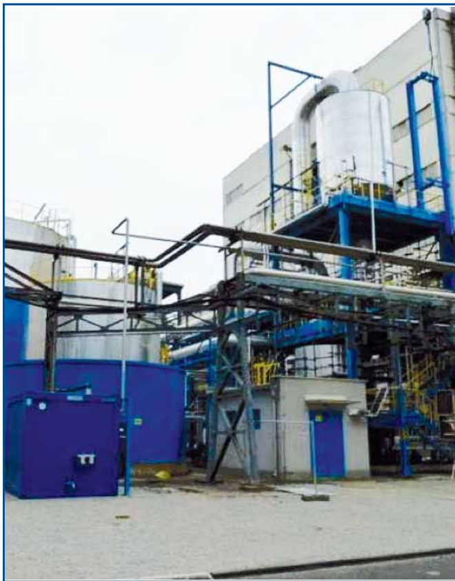
obr. 2 – Reakčná časť stavby – výrobná SA.
