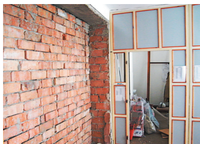
Kancelárske priestory pripravené na rekonštrukciu
