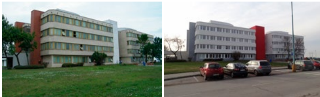
Stav pred a stav po rekonštrukcii
