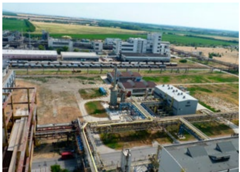
Obr. č. 1: Priestor za cirkulačnou stanicou chladiacej vody CV4
