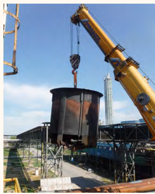
Demontáž trubkového zväzku kotla
