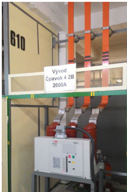
Hlavný prívod elektrickej energie pre Čpavok 4, zabezpečený z Hlavnej transformačnej rozvodne HTR II, pre požadovaný výkon 10 MW (na obrázkoch zľava reaktor, VN vypínač, ovládacia skriňa s ochranou).
