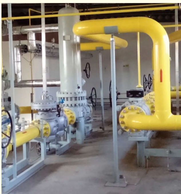
Nová regulačná stanica na dodávku zemného plynu pre výrobu Čpavok 4, bude zabezpečovať prívod zemného plynu z Plynovodu Tranzit a Medzištátneho plynovodu s objemom 55 000 m 3 /h a tlakom 4,6 MPa.
