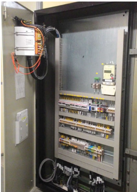
Hlavný prívod elektrickej energie pre Čpavok 4, zabezpečený z Hlavnej transformačnej rozvodne HTR II, pre požadovaný výkon 10 MW (na obrázkoch zľava reaktor, VN vypínač, ovládacia skriňa s ochranou).
