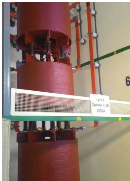
Hlavný prívod elektrickej energie pre Čpavok 4, zabezpečený z Hlavnej transformačnej rozvodne HTR II, pre požadovaný výkon 10 MW (na obrázkoch zľava reaktor, VN vypínač, ovládacia skriňa s ochranou).
