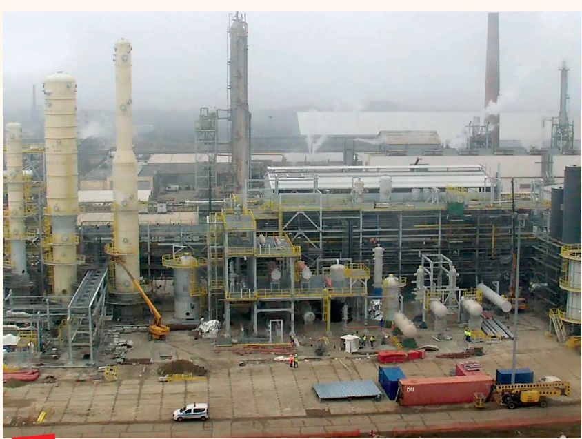
Obr. 1 Stavenisko Čpavok4 v roku 2017
