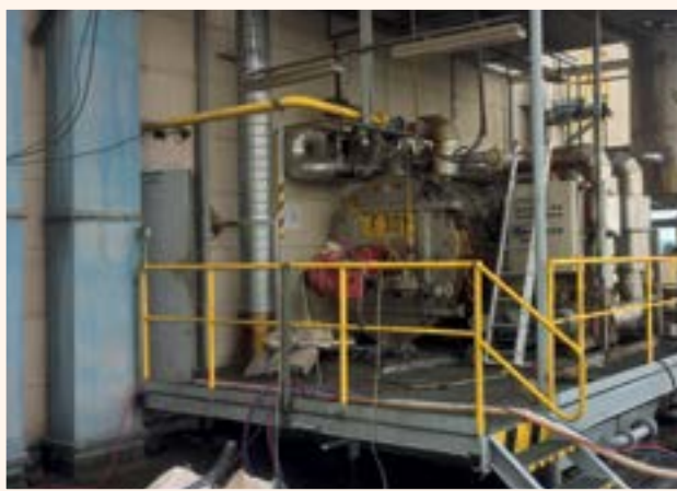
Stará kotolňa počas demontážnych prác
