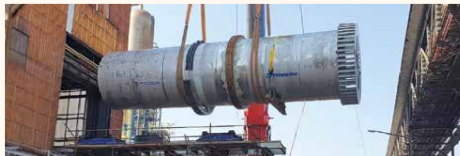
Výmena sušiaceho bubna na prevádzke LAD2
