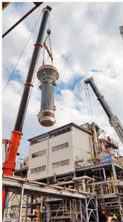
Výmena kotla na KD3
