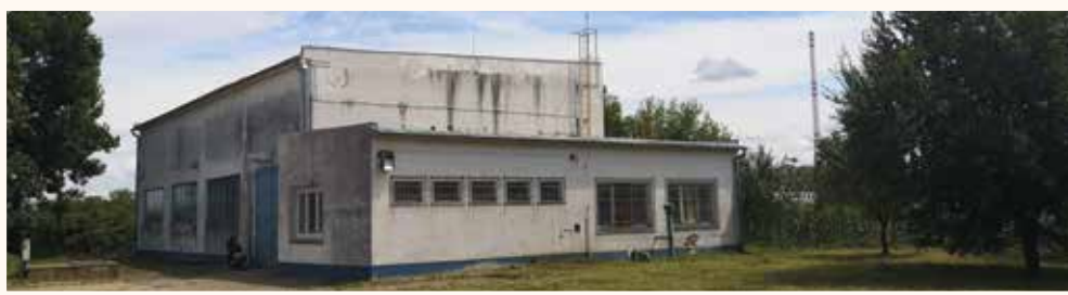
Objekt vodárne PV3 s pitnou vodou
