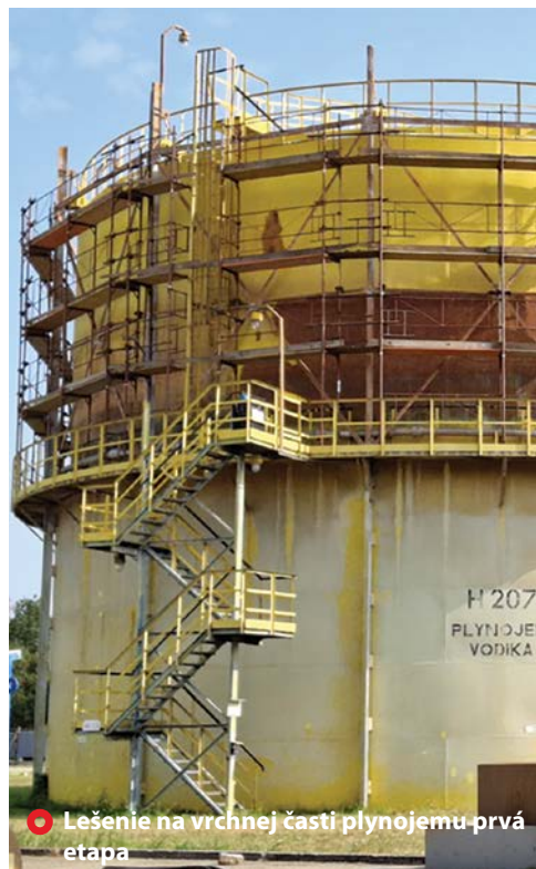
Stav plynojemu pred renováciou v roku 2024
