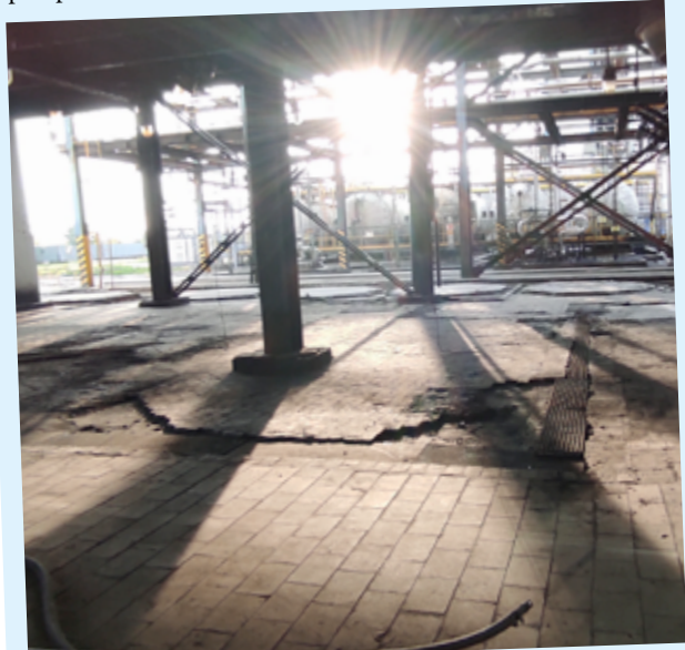
● Priestor v objekte po zlikvidovaní strojno-technologického zariadenia
