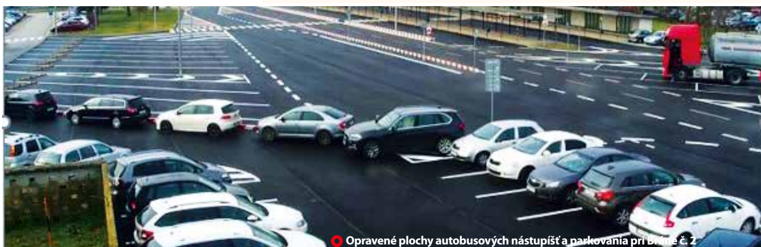
Opravené plochy autobusových nástupišť a parkovania pri Bráne č. 2
