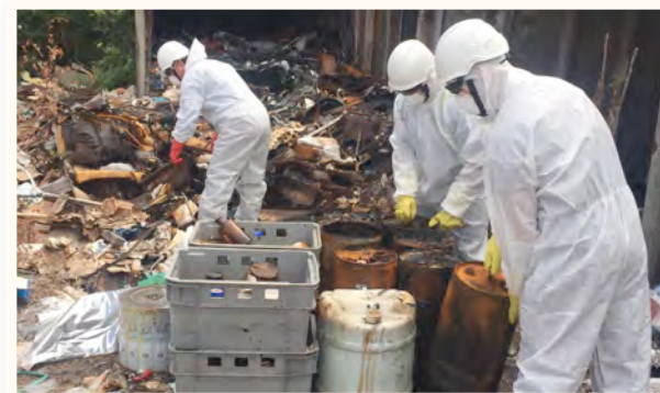
Odpratávanie nebezpečného odpadu
