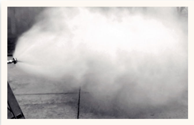
Skúška rozprašovacích hlavíc
