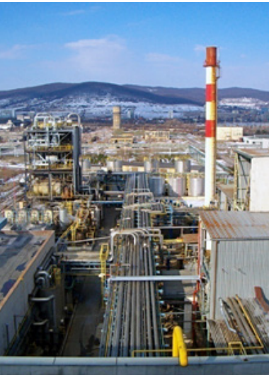
Pohľad chemika na Malé Karpaty zo strechy budovy Sulfenaxu
