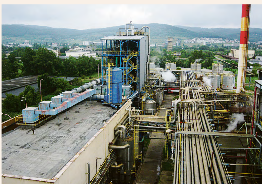
Pohľad na prevádzku Sulfenaxov
